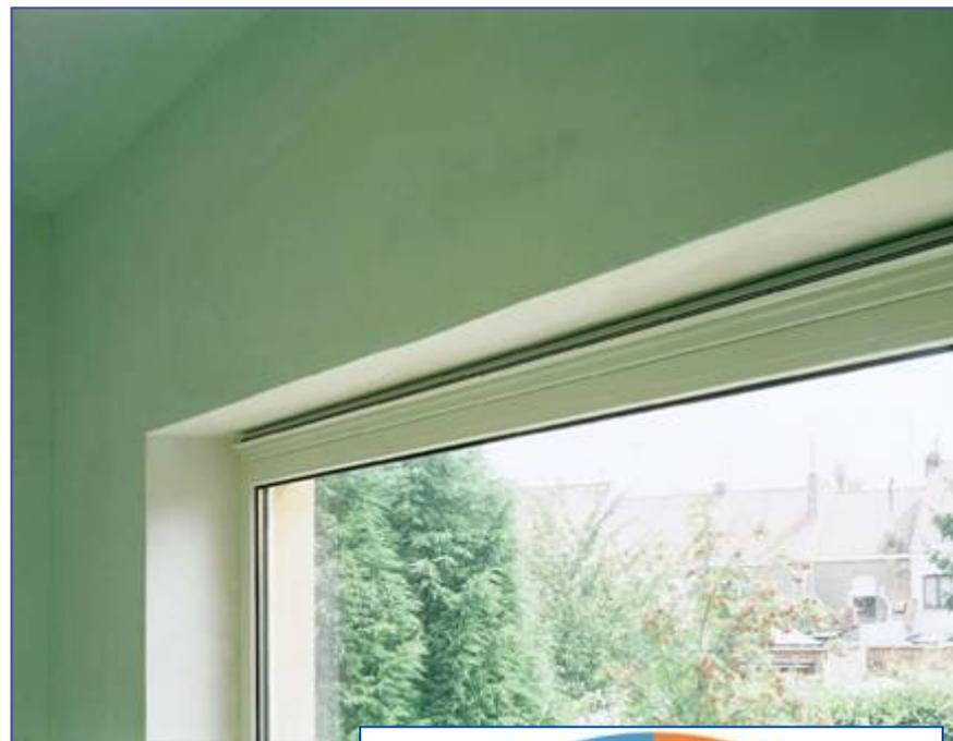
1. Саморегулируемый с термоизоляцией
